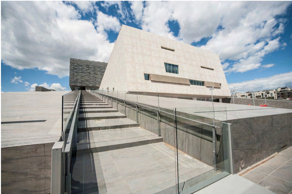
7. Rampe esterne (foto Raniero Carloni).
